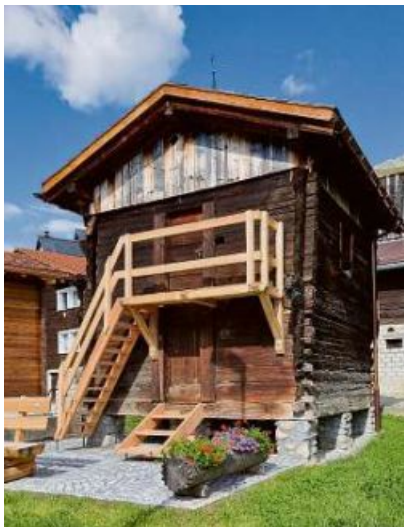
Zweistöckig: In das obere Geschoss der restaurierten «truasch» in Rueras führt nun eine hölzerne Aussentreppe. Pressebild
