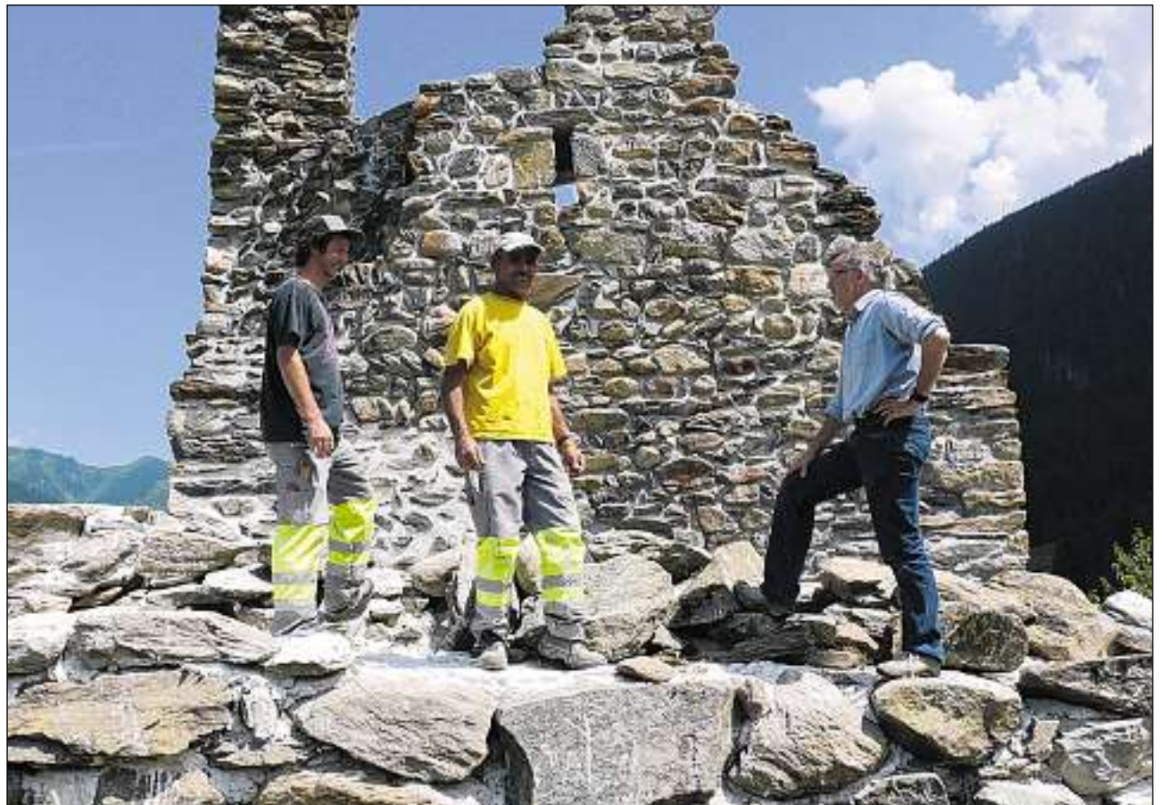
Las lavurs da sanaziun ein terminadas. Tarcisi Hendry (dretg) en discussiun cun dus collaboratur d'ina interpresa da baghegiar.
