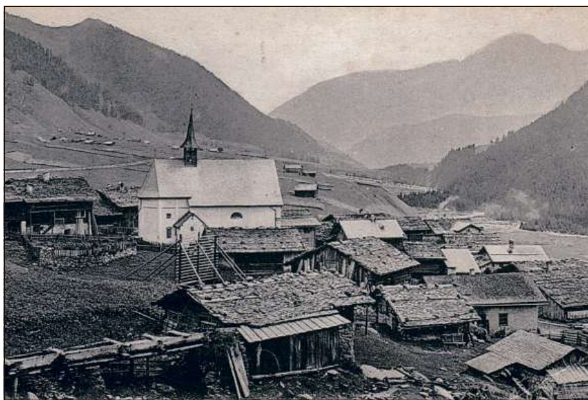
Ina dallas fotografias muossa l'industria d'antruras a Suloms, ils tetgs tuts cuvretgs cun slondas e cun crappa. La foto dat in'impreschiun dil maletg dil vitg all'entschatta dil 20avel tschentaner. En tschien onns ei succediu in svilup ed ina midada en tuts graus.
